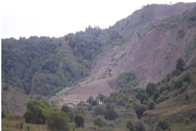
Рис.63. Гигантский оползень близ с.Бугарой
