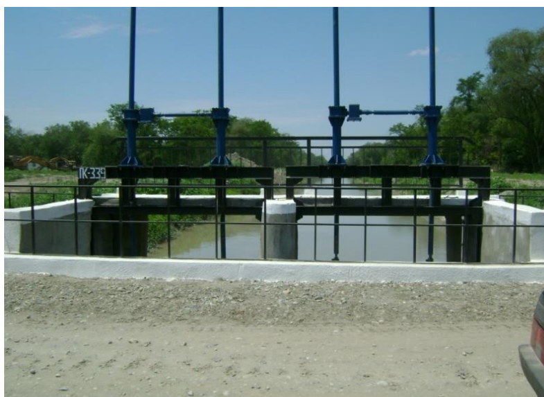
Рис.29. Шлюз Терско-Кумского оросительного канала
