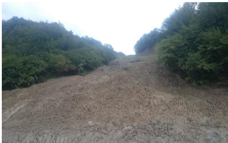
Рис.62. Тело оползня на автодороге Грозный – Шатой
