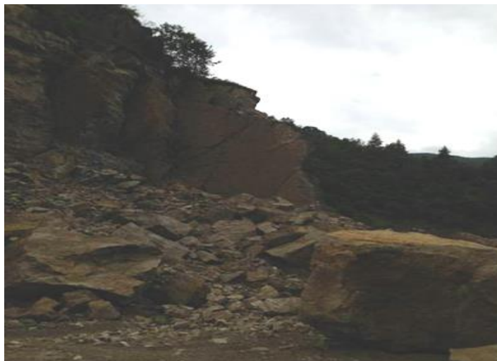
Рис.61. Обвальные процессы на участке автодороги Дай-Шарой.
