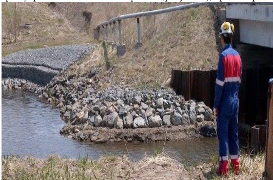
Рисунок 6. Укрепление берега ручья Голубого с помощью каменной наброски [6]
